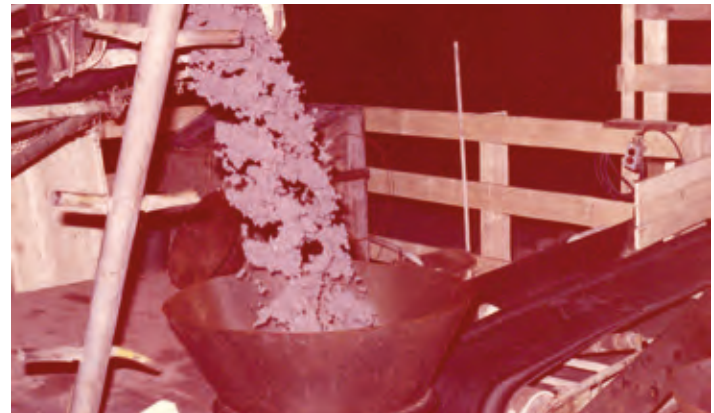
Verfüllung des Schachts mit Haufwerk.
