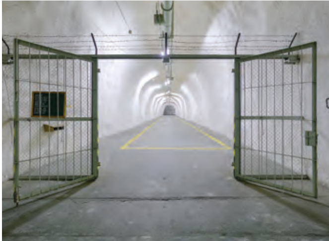
Lagerstollen im Logistik- und Lagerbereich.
