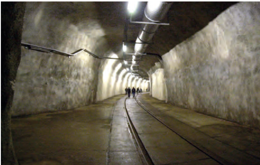
Eisenbahngleich in Richtung „Mundloch C“.
