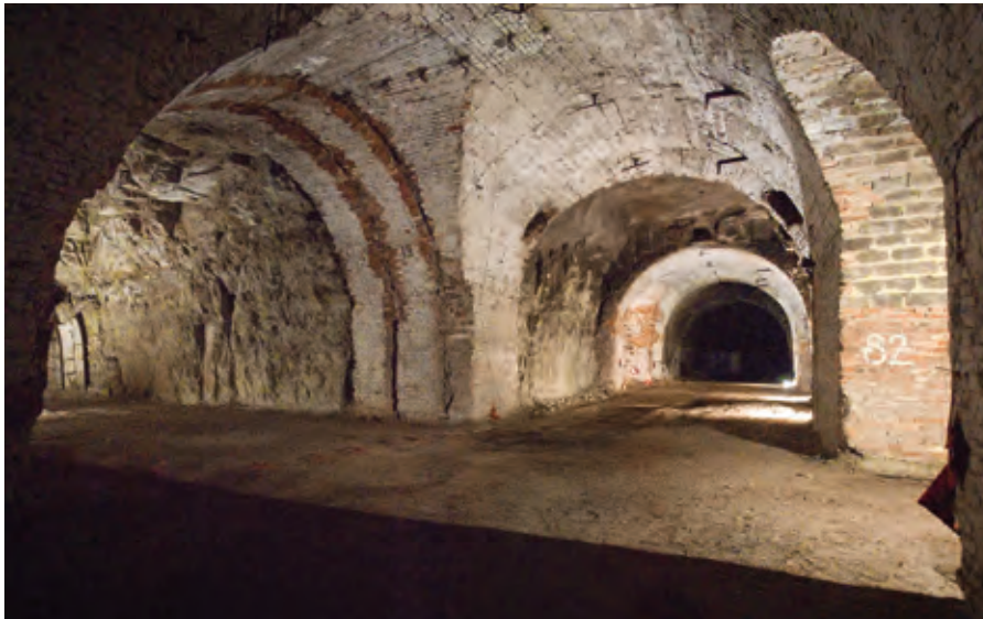
Stollenkreuzung mit ausgemauerten Eckpfeilern.
