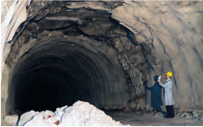
Standsicherheitsprüfung der Stollen 1993.
