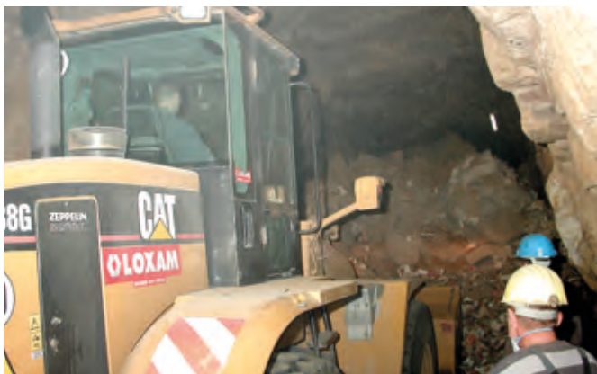
Per Radlader werden die Banknoten aus dem Stollen geholt.
