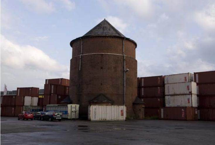
Abbildung 22: Außenansicht von Nordwesten
