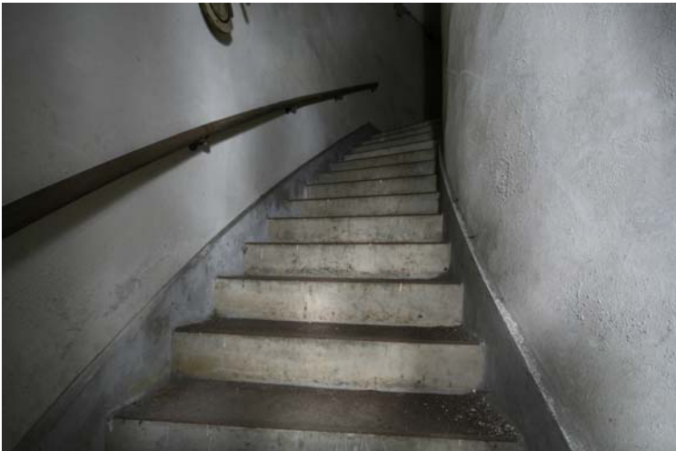
Abbildung 30: Blick in eines der Treppenhäuser
