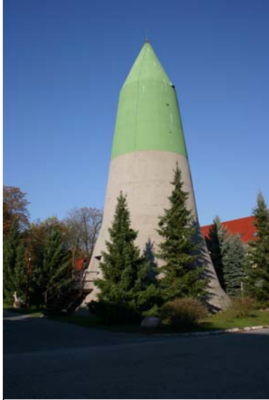
Abbildung 3: Luftschutzturm der Bauart Winkel (Wünsdorf)
