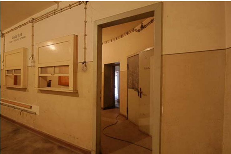
Abbildung 34: Erdgeschoß, Befehlsstelle: Blick Richtung Melderraum und Ausgang
