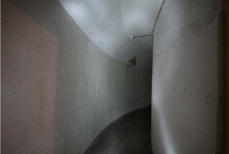
Abbildung 57: Schmalen Nebenraum über den Treppen, 5. Stock
