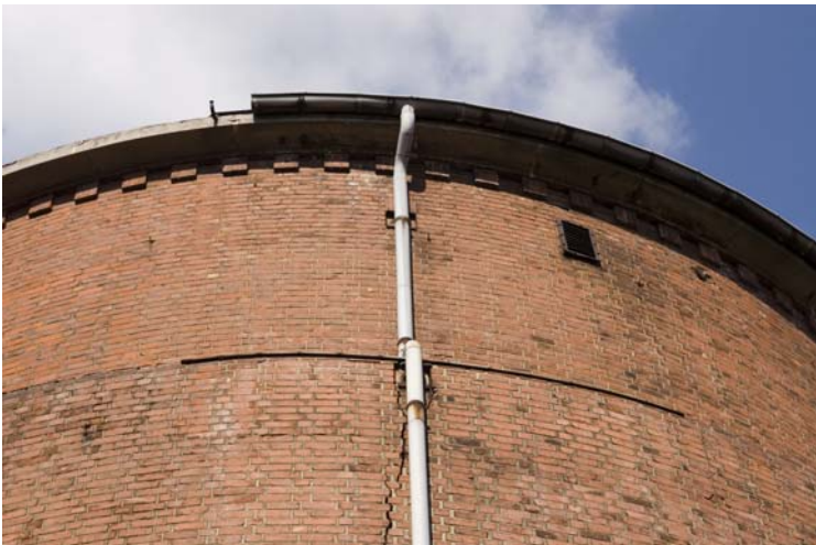
Abbildung 25: Detail: Ziegelrelief unterhalb der Traufe
