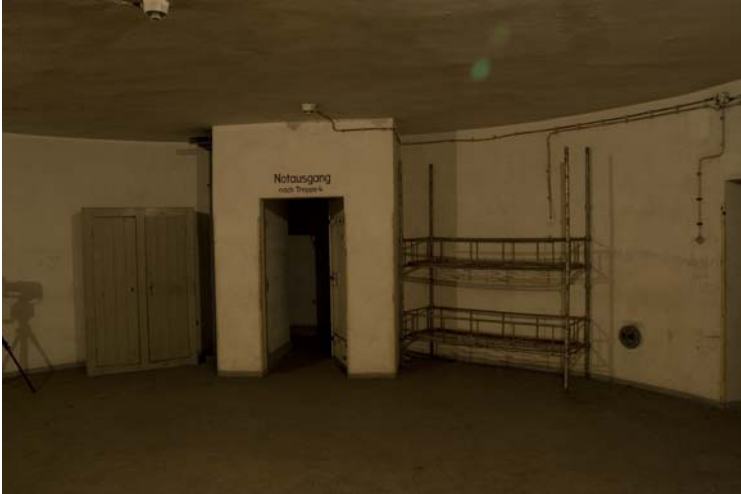
Abbildung 48: Aufenthaltsraum 3. Stock: Blick Richtung Treppenhaus
