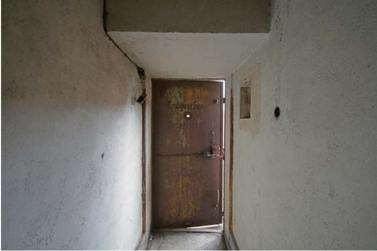
Abbildung 29: Schleuse des Erdgeschosses, Blick zur Außentür
