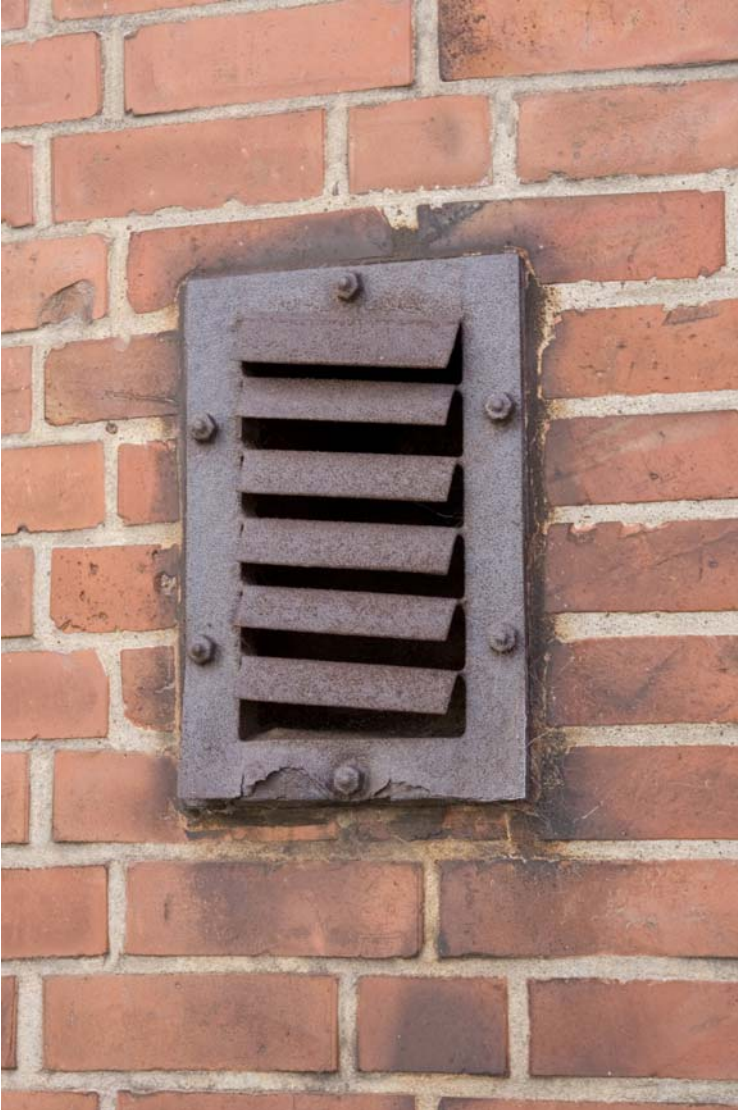
Abbildung 28: Äußeres Gitter zum Kanal der Druckklappe in der Schleuse
