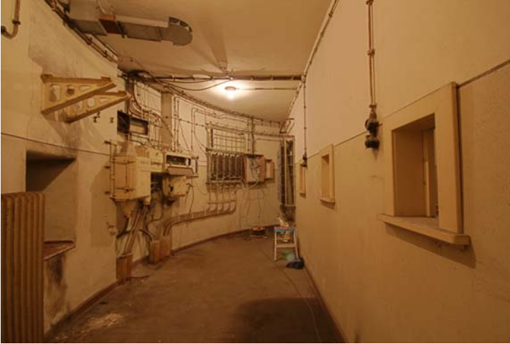
Abbildung 39: Erdgeschoß, Telefonraum: Blick in den Raum
