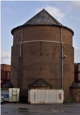
Abbildung 6: Ringtreppeurm Rossweg 20, Hamburg
