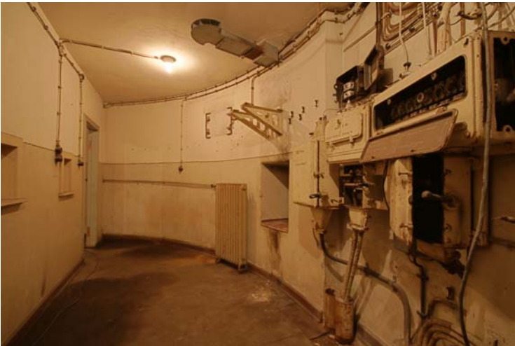
Abbildung 40: Erdgeschoß, Telefonraum: Blick in Richtung Durchgang zur Befehlsstelle
