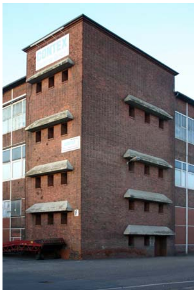
Abbildung 2: Treppenhausbunker im Hamburger Hafen
