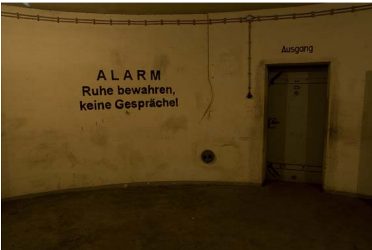
Abbildung 44: Aufenthaltsraum 2. Stock: nachträglich angebrachte „falsche“ Wandbeschriftung
