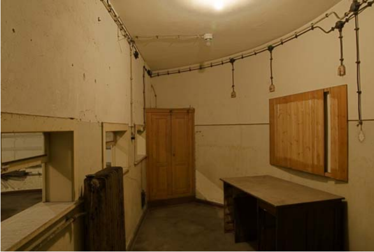
Abbildung 31: Erdgeschoß, Melderraum: Blick vom Eingang nach rechts
