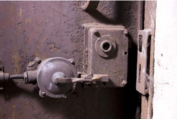
Abbildung 66: Türschloss mit Schalter/Taster, Innenseite Außentür Erdgeschoß
