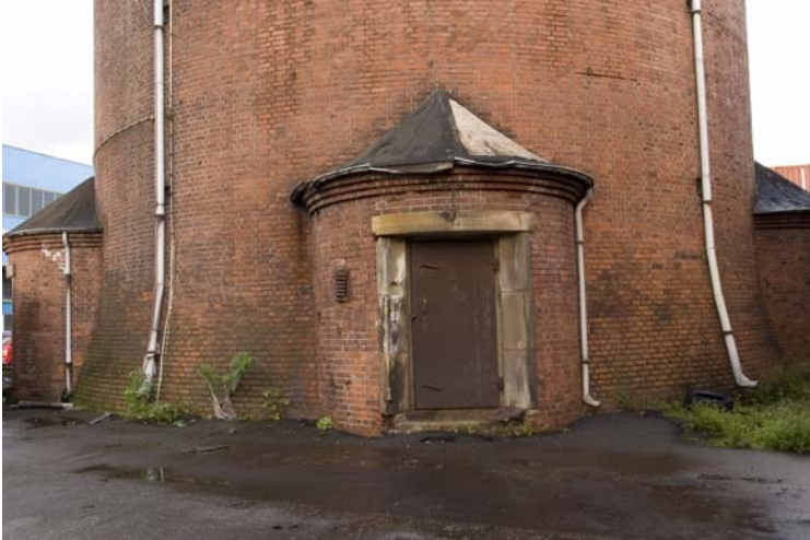
Abbildung 24: Schleusenzugang zum 3. Stock
