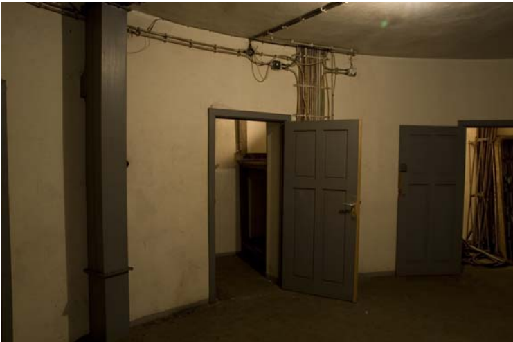
Abbildung 49: Aufenthaltsraum 3. Stock: Blick Richtung Nebenräume
