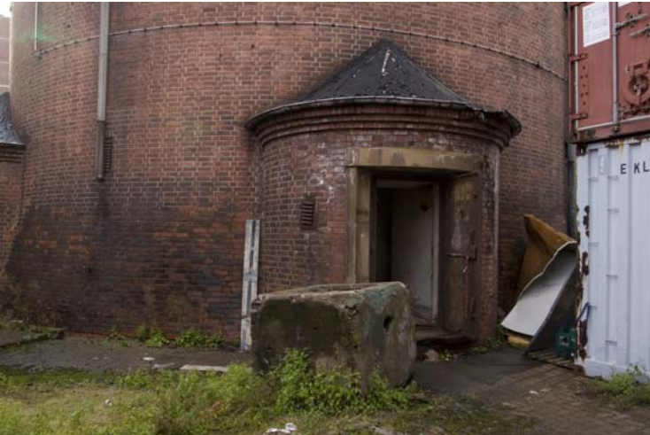
Abbildung 23: Schleusen Zugang zum Erdgeschoss
