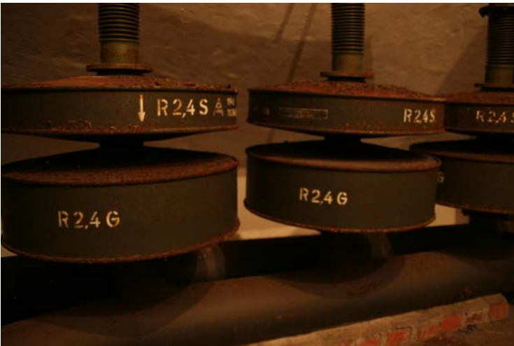
Abbildung 62: Dachgeschoß: Filter
